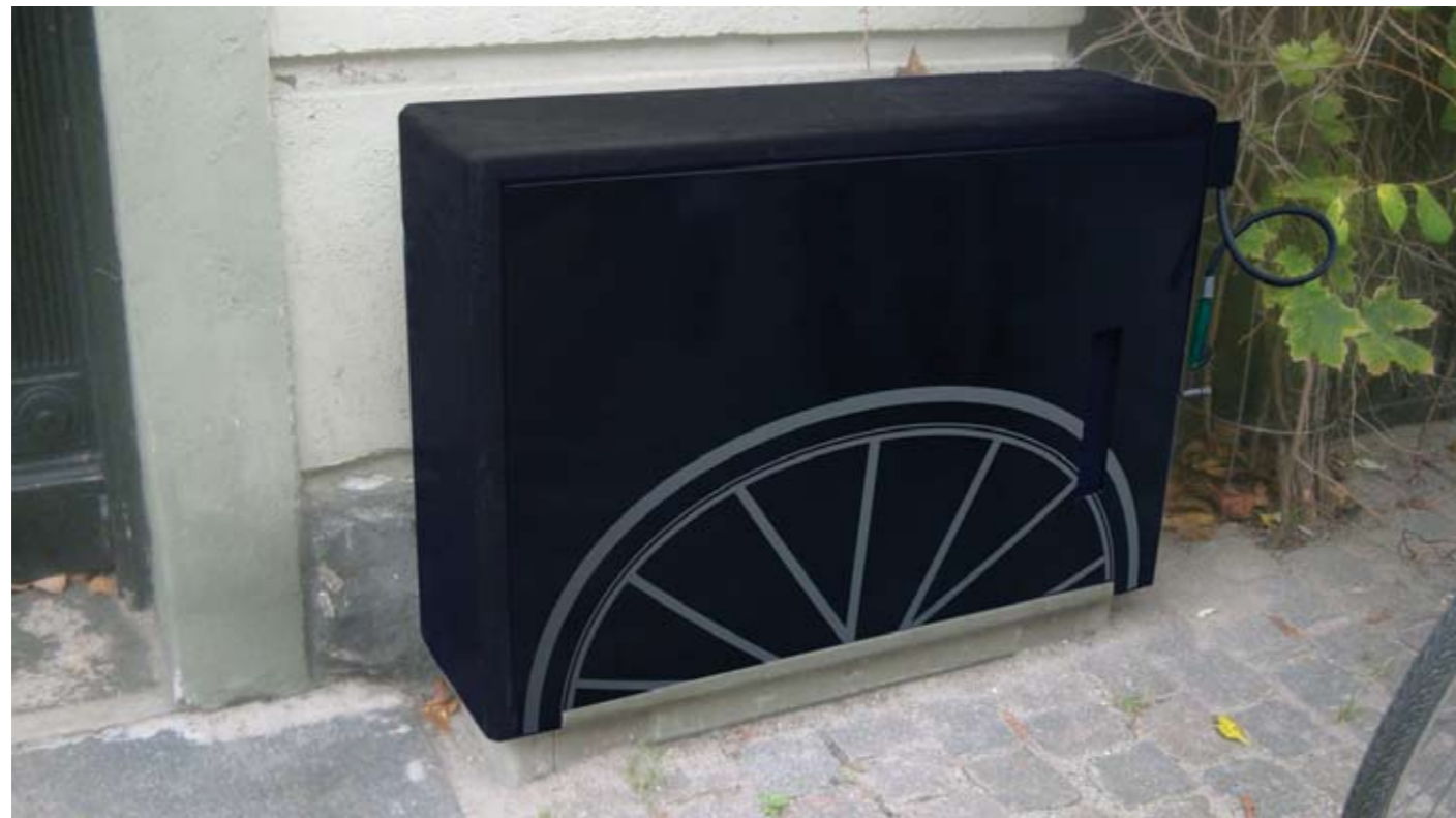
Teknikskab med pumpestation.
