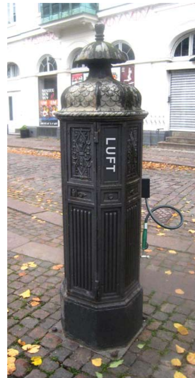
Klassisk Teknikskab med pumpestation.
